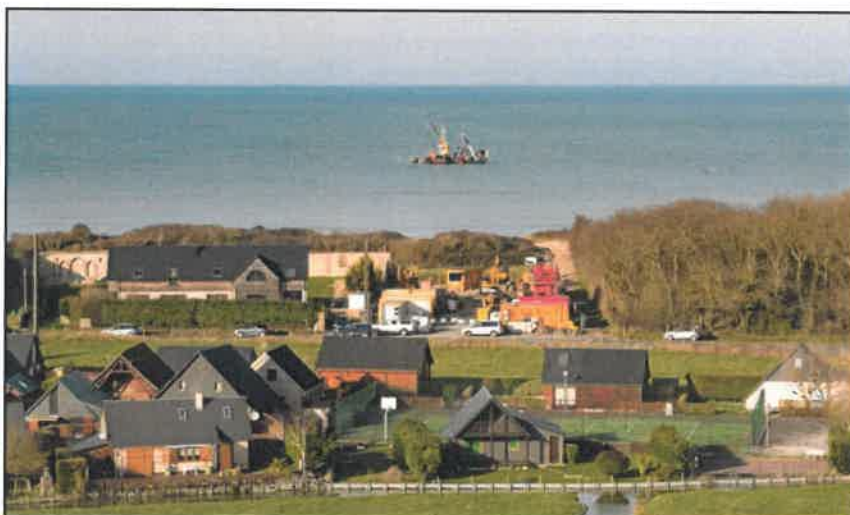
Exemple d'un chantier de forage dirigé sous la dune du projet France - Grande-Bretagne (IFA2)
