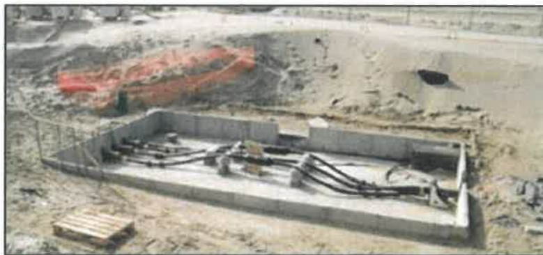
Figure 11 : Chambre d'atterrage en cours de construction
