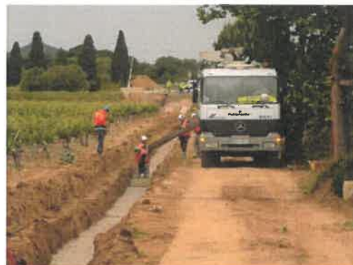
Photos de la pose du génie civil d'une liaison souterraine à courant continu en fourreaux PVC (liaison Baixas - Santa-Llogaia)
