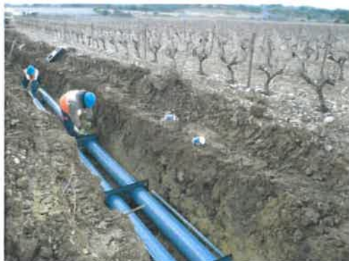
Photos de la pose du génie civil d'une liaison souterraine à courant continu en fourreaux PVC (liaison Baixas - Santa-Llogaia)
