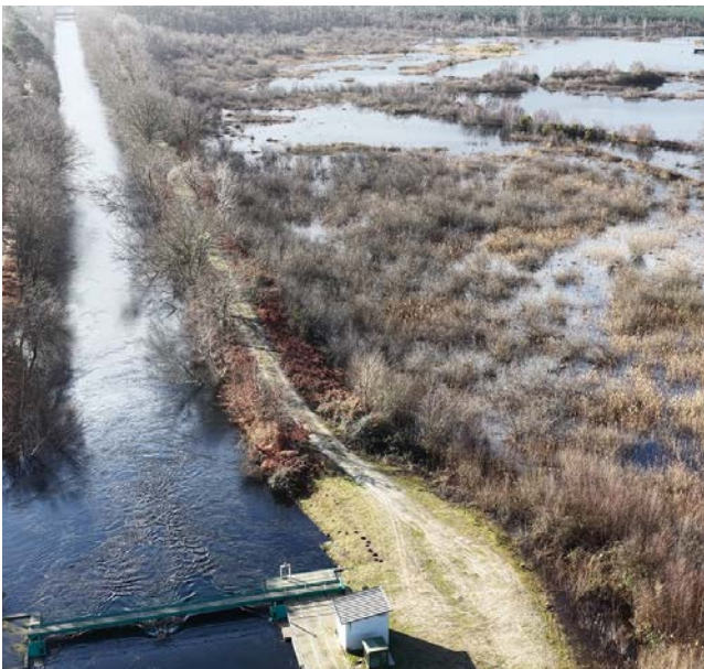
Délestage du canal de batejin vers une zone humide
